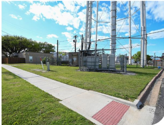
Existing Chestnut EST Site
