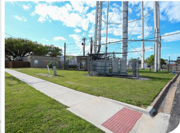
Existing Chestnut EST Site
